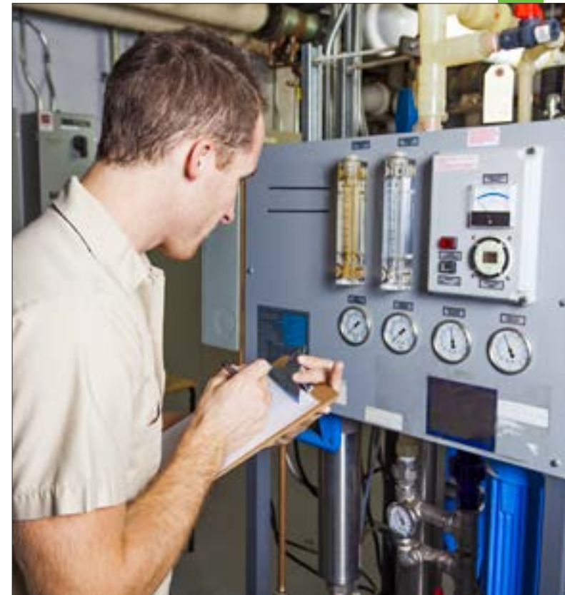
Técnico inspeccionando el sistema en el cuarto de calefacción. Adobe Stock Photo
