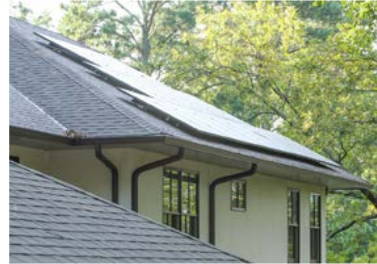
Paneles solares sobre el techo de la rectoría de la iglesia Immaculate Heart of Mary en Atlanta. Treinta y cuatro paneles solares fueron instalados en julio 2020. Esta foto es del lado noroeste, los demás paneles están en el lado sureste. El proyecto fue financiado a través del #iGiveCatholic 2018 de la parroquia. Foto de Michael Alexander, The Georgia Bulletin
