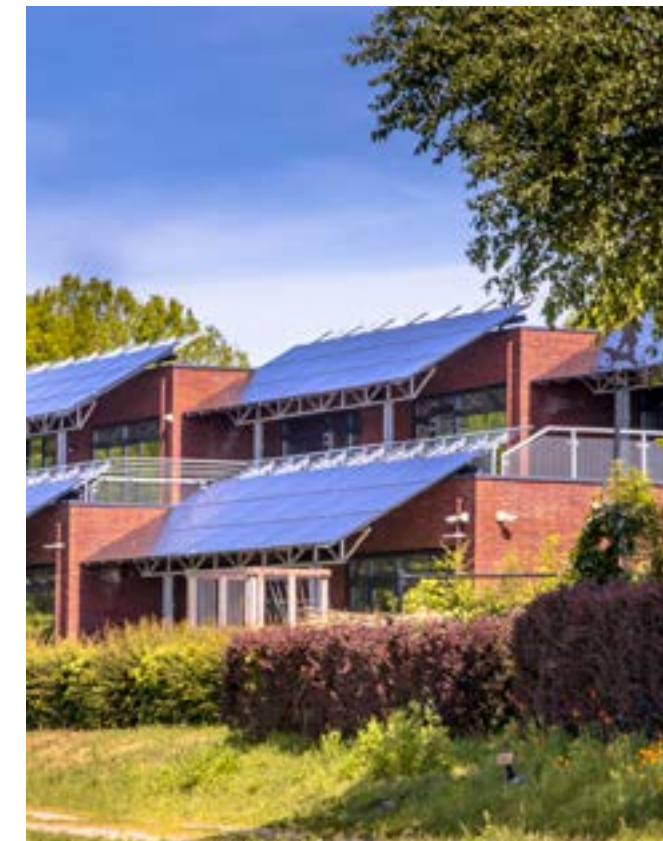
Escuela pública con paneles solares como elementos de protección solar. Adobe Stock Photo
